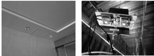
図 7 天井（左図）とその内部に取り付けた IMES 送信機（右図）
