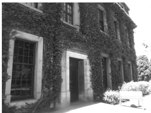
Capetown大学のworkshopが行なわれた建物
