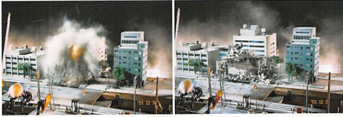
◀ ビルの全壊 (詳細は「特撮とVR」20頁参照)
