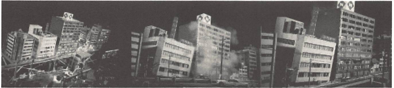
図3 ビルの中途階崩壊 *口絵にカラー版掲載
