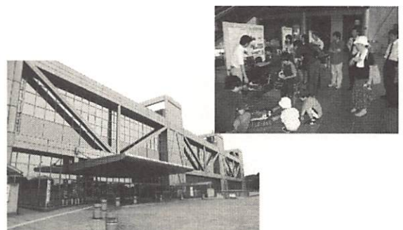
仙台市科学館とエントランスホールでの特別展示の様子
