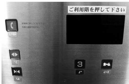
写真2 エレベータのボタン（悪い例）
