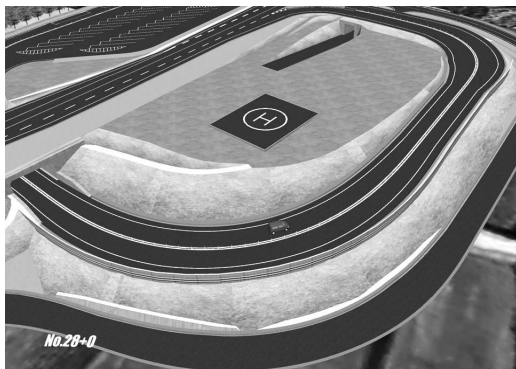
図1 内側盛土が高いループ部
